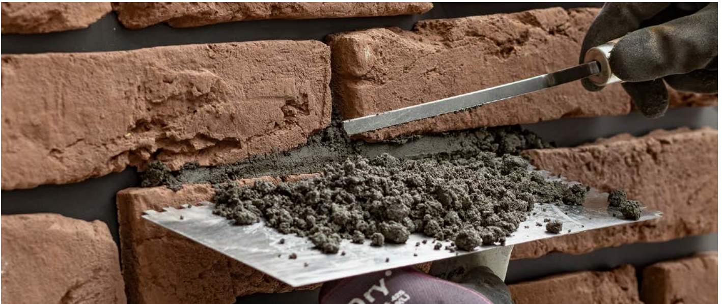
Fig. 19 Rejuntado de revestimientos de forma regular con llana para lechada Grouting regular shaped cladding with a grouting trowel
