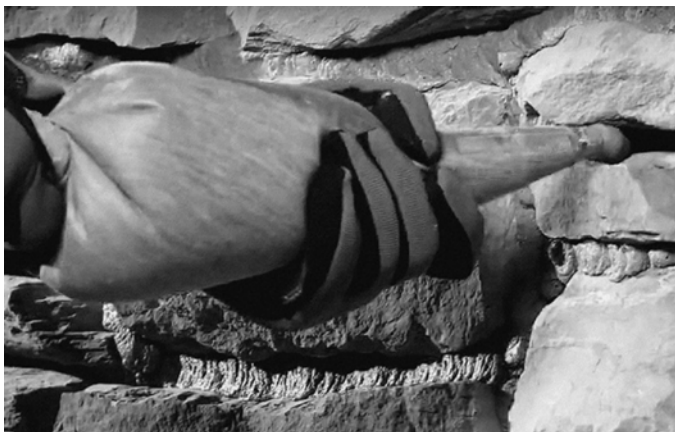
Fig. 20 Rejuntado de revestimiento con manga. Grouting the cladding with a sleeve.
