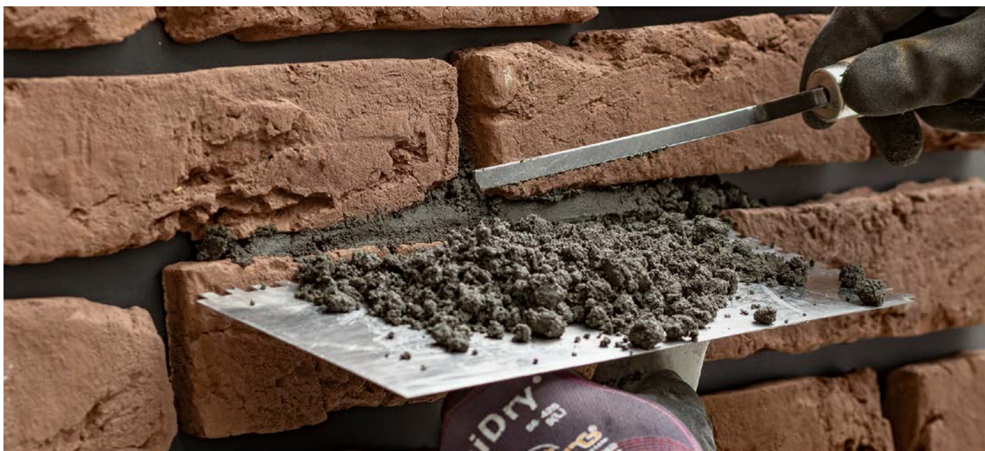
Rys. 19 Spoinowanie okładzin o regularnym kształcie kielnią spoinówką
