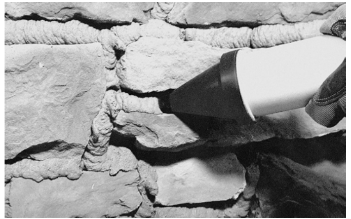
Rys. 21 Spoinowanie z użyciem pistoletu Fig. 21 Caulking with the gun
